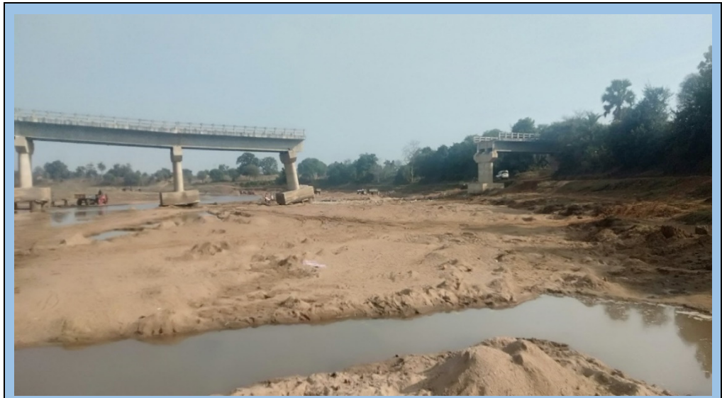
चित्र 2.13: पाकुड़ जिले के चंडालमारा में बंसलोई नदी पर पुल की क्षतिग्रस्त पाटें
