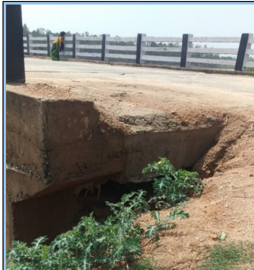
चित्र 2.16: पलामू जिला के पांकी प्रखंड में सरैया-झलखंडी के बीच अमानत नदी पर पुल के पहुँच स्लैब के पास फ्लैक में बहा हुआ पहुँच
