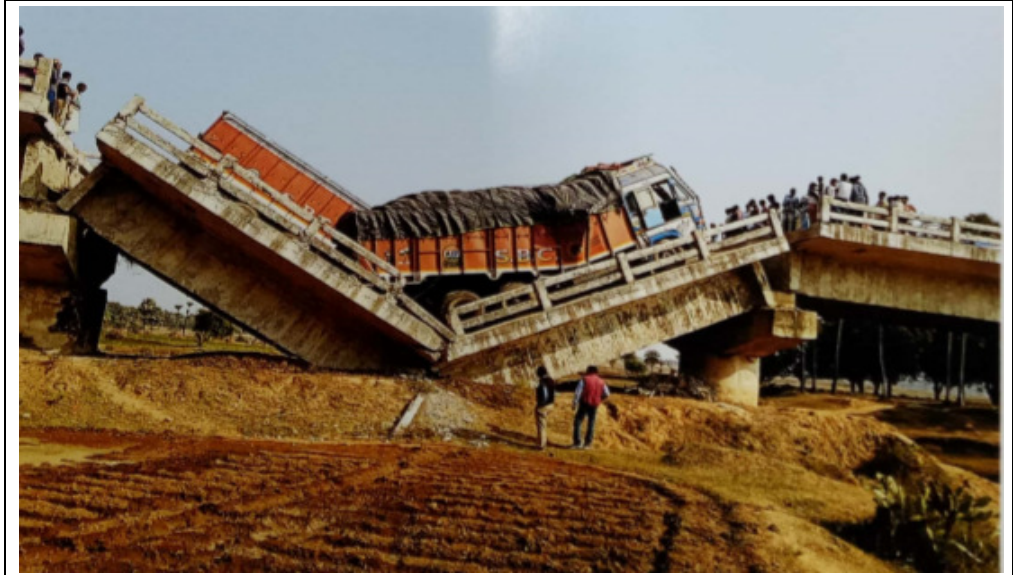
चित्र 2.14: गोडडा जिले के पथरगामा प्रखंड में कोरका से पकरिया पथ पर पुल का क्षतिग्रस्त पट (प्रमंडल की संचिका से ली गई तस्वीर)
