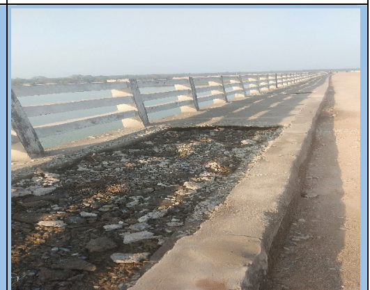
चित्र 2.19: सरायकेला जिला के ईचागढ़ प्रखंड के खोकरो-करकीडीह पथ के बीच स्वर्णरेखा नदी पर पुल में टूटी स्लैब
