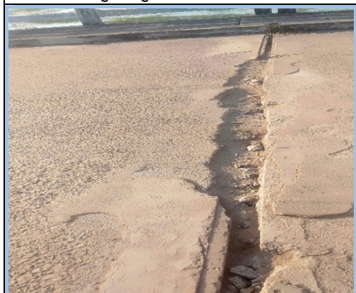
चित्र 2.18: सरायकेला जिला के ईचागढ़ प्रखंड के खोकरो-करकीडीह पथ के बीच स्वर्णरेखा नदी पर पुल में विस्तार- जोड़ की अनुपस्थिति
